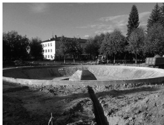
Рис. 12. Объекты, напечатанные аддитивным способом компанией АМТ-Спецавиа: а — жилой дом в Ярославле; б — Палехский фонтан в Ивановской области
