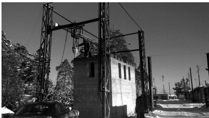
Рис. 11. Строительный 3D-принтер среднего формата AMT S-6044 LONG 2
