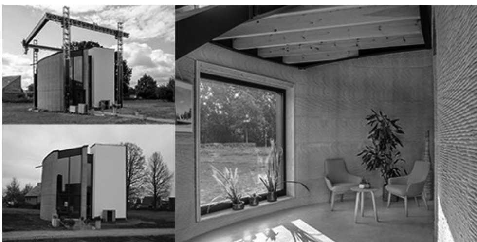
Рис. 6. Двухэтажный жилой дом в Бельгии, «распечатанный» на 3D-принтере
