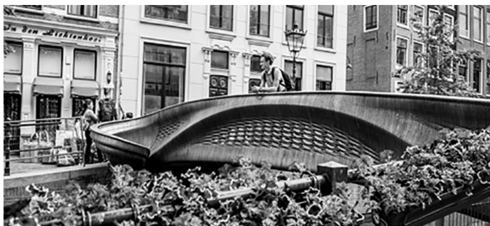
Рис. 4. Железобетонный мост в Амстердаме, построенный аддитивным способом
