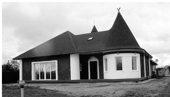
Рис. 12. Объекты, напечатанные аддитивным способом компанией АМТ-Спецавиа: а — жилой дом в Ярославле; б — Палехский фонтан в Ивановской области
