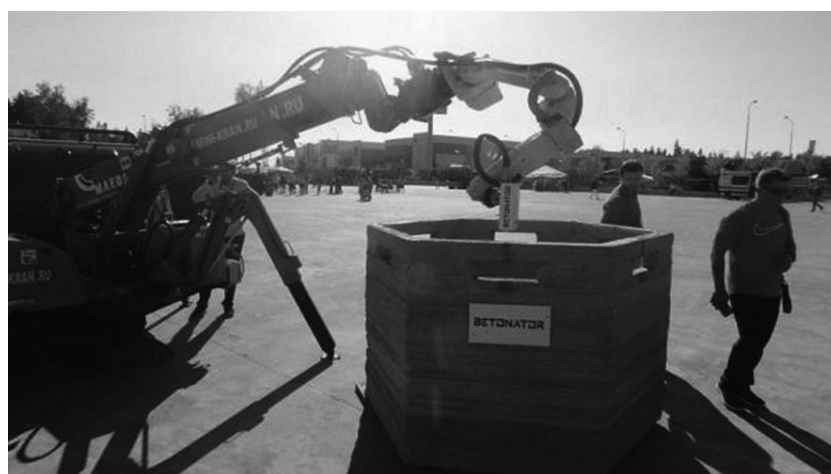
Рис. 14. Строительный 3D-принтер, проект «Бетонатор»
