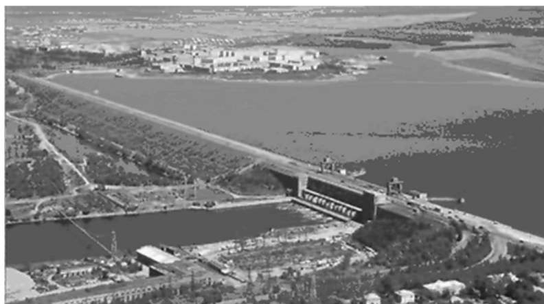
Рис. 1. Плотины, имеющие тело из местных материалов
